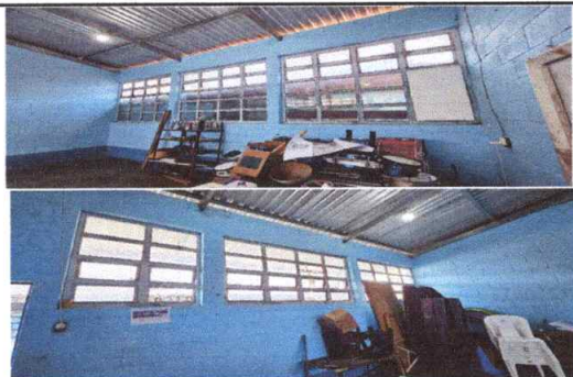
Foto 5: Sustrucción de ventana de madera por PVC mas vidrio
