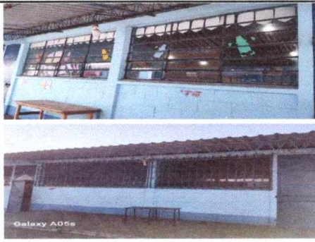
Foto 6: Sustrucción de ventana de madera por PVC mas vidrio
