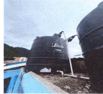
Foto 14: Sustitución de depósito de agua 1100 lt
