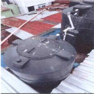
Foto 13: Sustitución de depósito de agua 1000 lt
