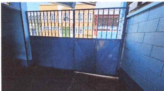
Foto1: Sustrucción de portón de metal
