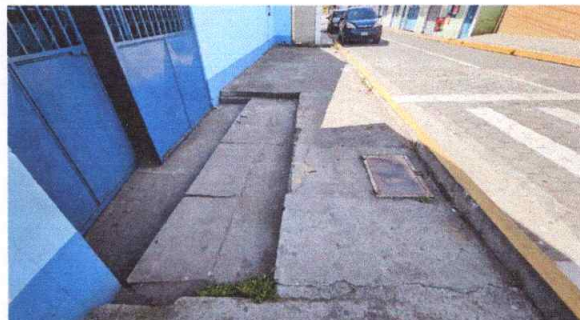
Foto 2: Reparación de banquetas de concreto
