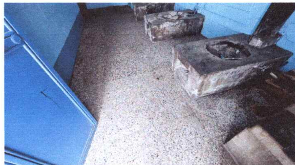
Foto 8: Reparación de piso cerámico
