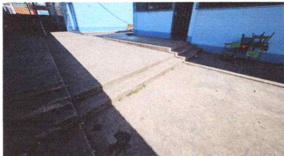
Foto 7: Reparación de planchas de concreto de patio
